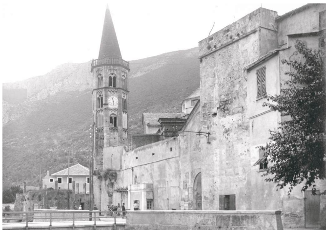
Fotografia della situazione antecedente al restauro del 1932: si noti l'assenza del passaggio pedonale e la presenza del casello del Dazio, della merlatura unita e dell'intonaco sulle mura
