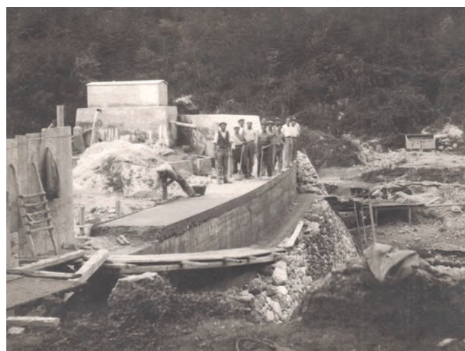
La ricostruzione della diga degli "scogli rotti" (chiusa) a seguito della inondazione del 1926
