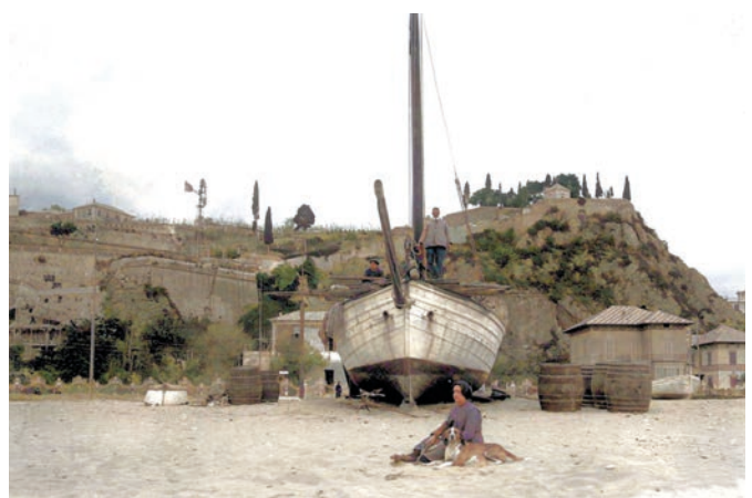
Fotografia di inizio XX sec.: un cantiere sulla spiaggia alla base di Castelfranco. Banca delle Immagini, fondo Campi
